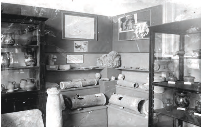
Рис. 25. Трубы водопровода и отопления терм Харакса в экспозиции Ялтинского музея краеведения в 1930-е гг. (по: Вдовиченко, Турова 2015: 139, рис. 1) Fig. 25. Pipes of water supply and heating of the thermae Charax in the exposition of the Yalta Museum of Local Lore in the 1930s (by: Вдовиченко, Турова 2015: 139, fig. 1)
