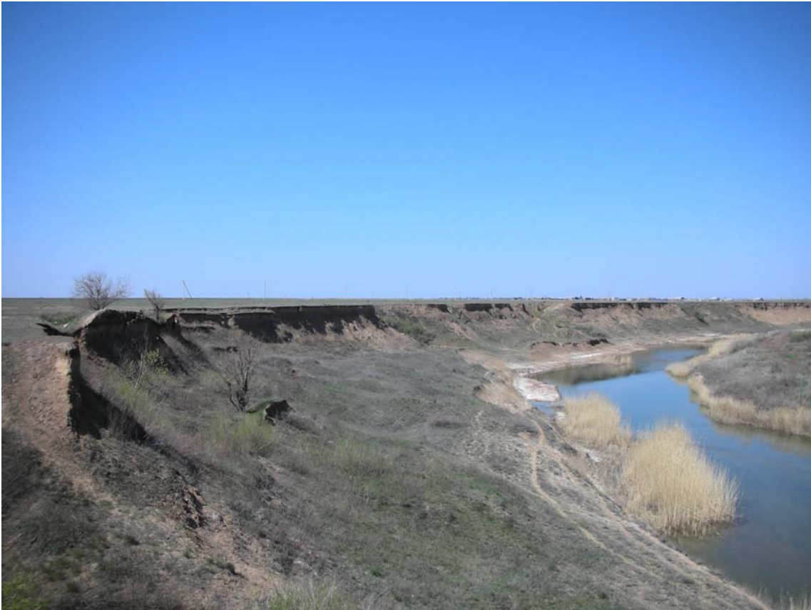
Рис. 2.5. Правый берег реки Большой Узень с оползневыми телами. Фото Н. В. Пичугиной (2010 г.).
