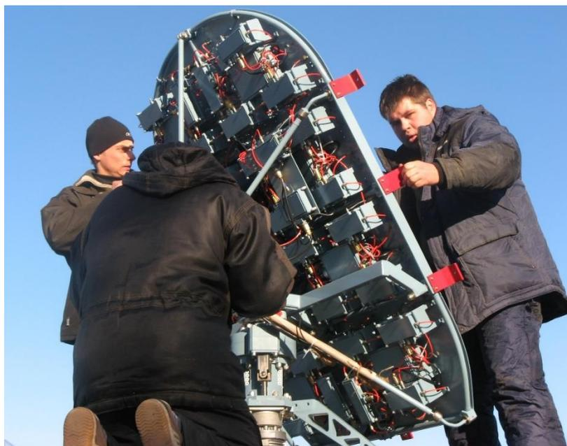
Рисунок 8 – Установка антенны АФАР на крыше аэрологической станции
