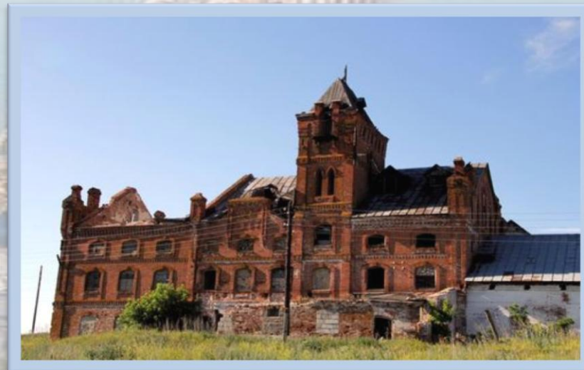
Мельница С. А. Устинова, построена в 1907 г., с. Первомайское, Ртищевский район
