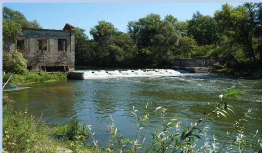
Плотина разрушенной ГЭС, с. Большой Карай, Романовский район
