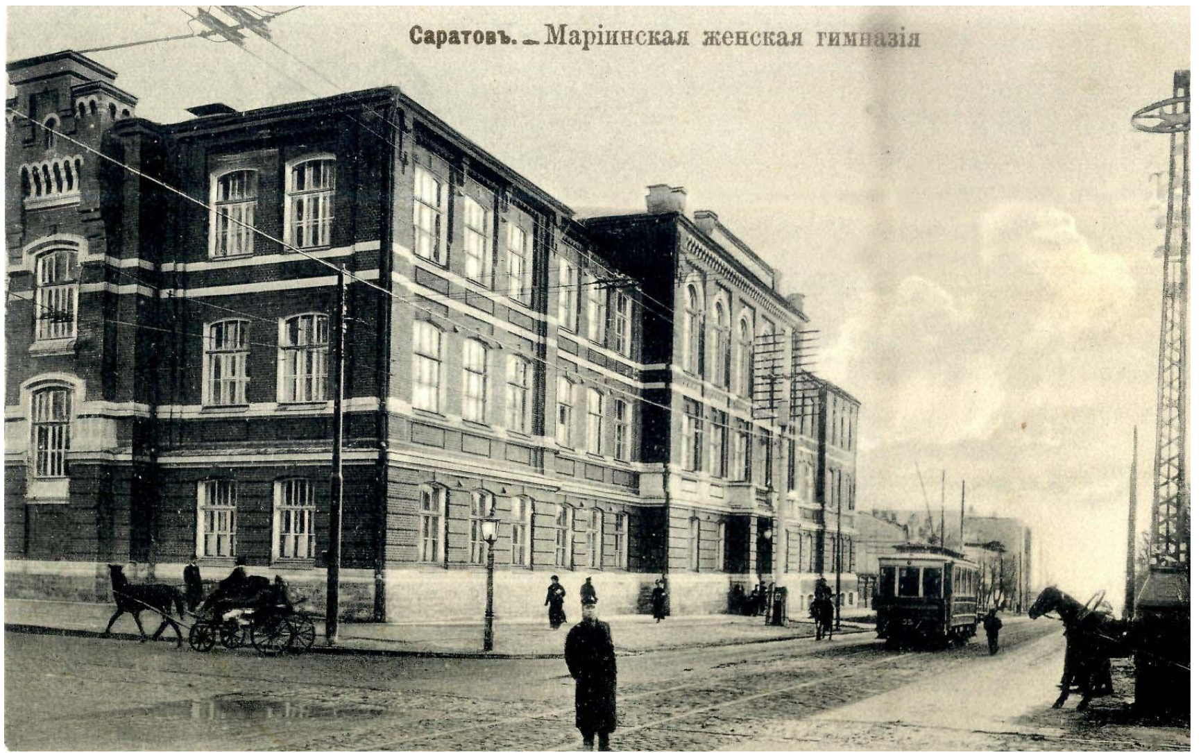
Здание Мариинской женской гимназии (ул. Александровская, ныне — ул. М. Горького)
